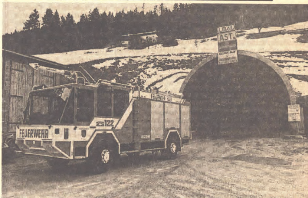
FÜR DAS NORDPORTAL der Eisenbahnumfahrung Innsbruck sind die Feuerwehren von Hall, Tulfes und Volders zuständig. Diese Wehren werden mit zusätzlichen Gerätschaften ausgestattet. Foto: Zimmermann
